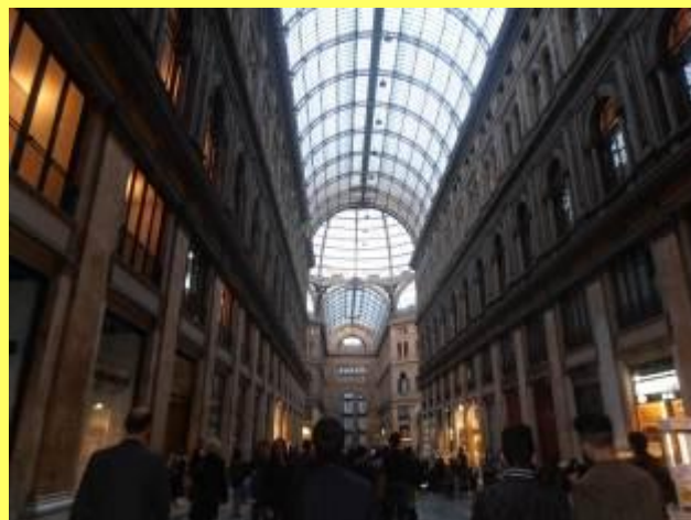
L'interno della galleria (Napoli)
